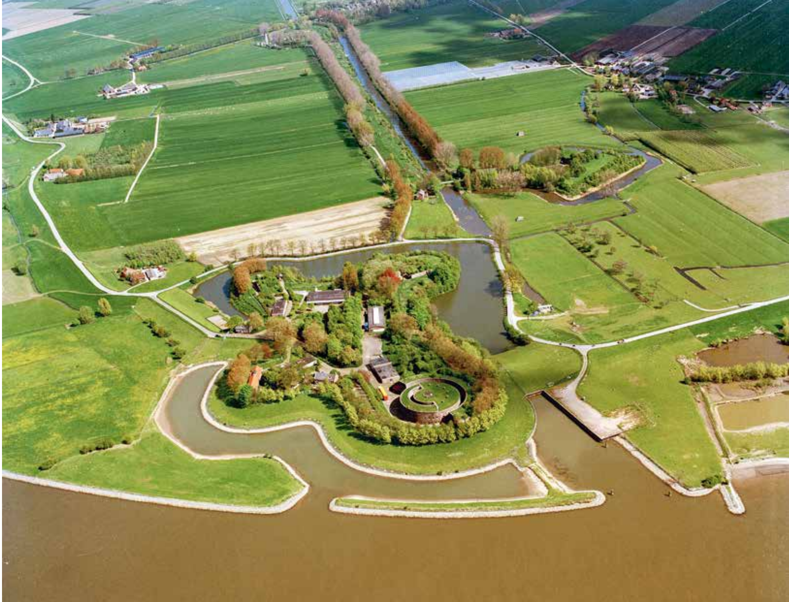
De Lekdijk is vele malen verbeterd en opgehoogd, maar ook talloze malen doorgebroken. Ook werden bressen in de dijk gemaakt in de vorm van schutsluizen, inlaten en gemalen, zoals hier bij fort Honswijk. Voor de laatste dijkverzwaring moest de inlaatsluis verdwijnen (zie dam rechts). foto HUA
