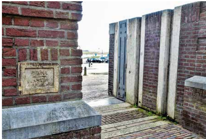
In de Havenpoort in Wijk bij Duurstede zijn de sleuven nog aanwezig, maar tegenwoordig kan de doorgang ook elektrisch worden afgesloten met een stalen schuifdeur die in de muur is verwerkt. foto Kees Volkers
