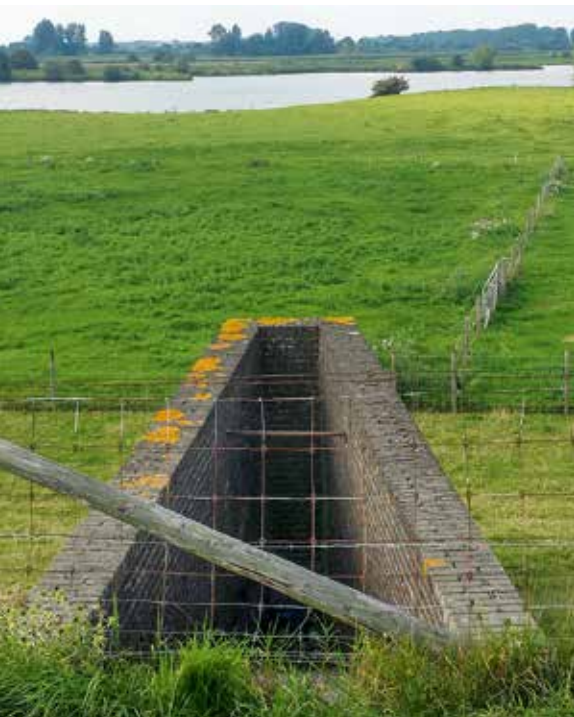
Restanten van het peilschaalhuisje bij waakhuis Den Oord. Bij hoogwater las de waakmeester, die in het nabijgelegen waakhuis bivakkeerde, regelmatig het waterpeil af. Het water stroomde binnen via een instroomopening onderaan de dijk (nu dichtgemetseld). Het peil was zo, onafhankelijk van de golfslag op de rivier, af te lezen op een peilschaal.
