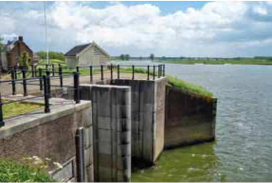
Links en rechts: Ook behorend tot het dijkerfgoed zijn de schotbalkloodsen op de plekken waar een bres in de dijk is gemaakt, zoals de witte loods bij de Oude Sluis in Vreeswijk, waar de Vaartse Rijn in de Lek uitmondde. Deze sluis is nu dichtgemetseld voor de scheepvaart, maar er kan nog wel water worden ingelaten. foto links Jan Ausems, foto rechts Kees Volkers
