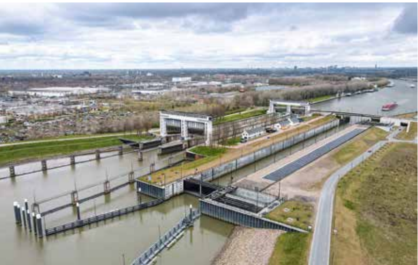
De Prinses Beatrixsluizen vormen via het Lekkanaal een bres in de Lekdijk voor de scheepvaartverbinding tussen de Lek en het Amsterdam-Rijnkanaal. Ze zijn in 1938 als eerste bouwwerk in Nederland vernoemd naar de net geboren prinses Beatrix. foto Jan Ausems
