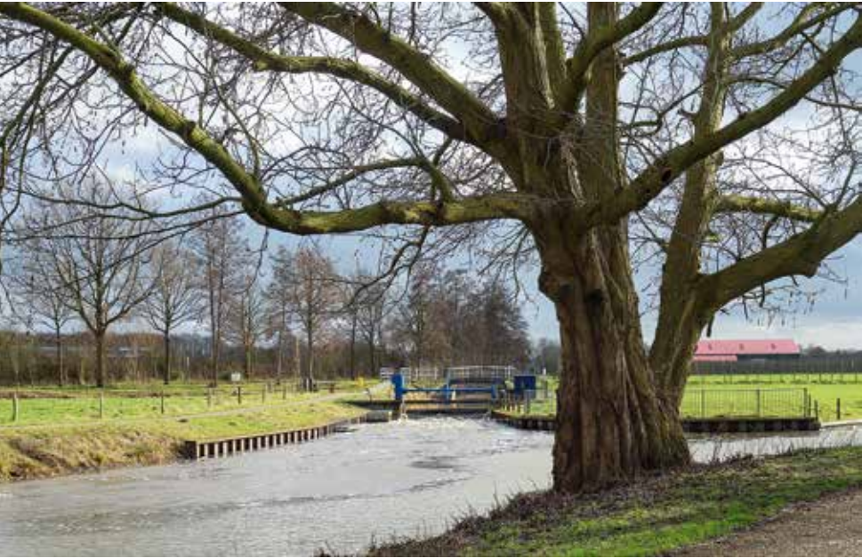
Een wetering maakt gebruik van een natuurlijk verval. Het hoogteverschil is goed te zien bij de stuw in Odijk, waar de Langbroekerwetering uitmondt in de Kromme Rijn. De stuw is geplaatst in de jaren 70, toen de Langbroekerwetering haar functie als vaarwater voor schippers uit het Kromme-Rijngebied verloren had. foto Kees Volkers
